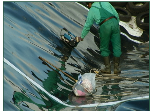
Veszélyes hulladéklerakó szigetelése
